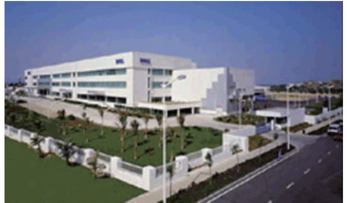
デルの主要な製品の組立拠点として機能する中国・廈門にある CCC (China Customer Center)。
