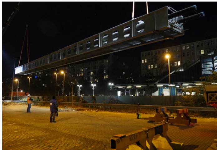
Bau von Fernwärmeleitungen (Quelle: Büro Gronow)
